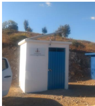
Imagen 51. Cuarto de control Santa Cecilia Jalieza Fuente: Propia autoría.
