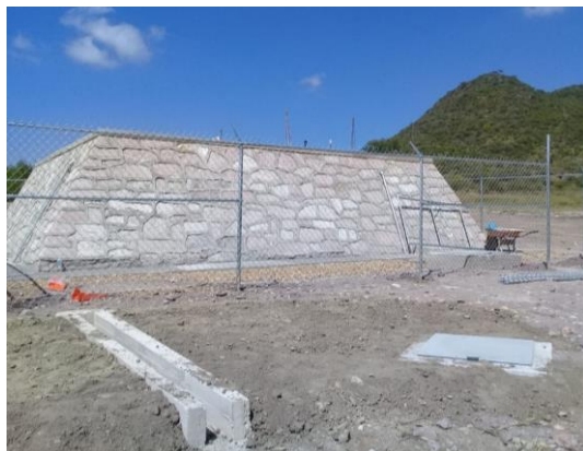
Imagen 42. Tanque de agua potable superficial. Fuente: Propia autoría.
