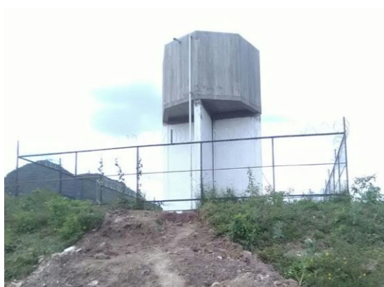
Imagen 43. Tanque de agua potable elevado. Fuente: Propia autoría.
