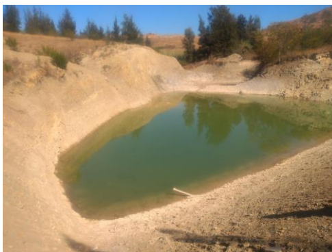
Imagen 48. Olla de captación de agua pluvial. Fuente: Propia autoría.
